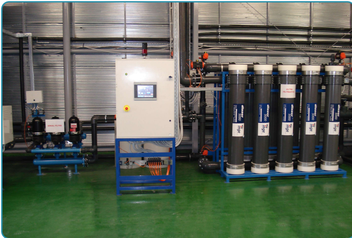
Türkiye'de, kaynak suyu dolmu tesisinde, Ultra Filtrasyon koruyucu filtresi olarak ARKAL Diskli Su Filtresi, 50 m 3 /h.
