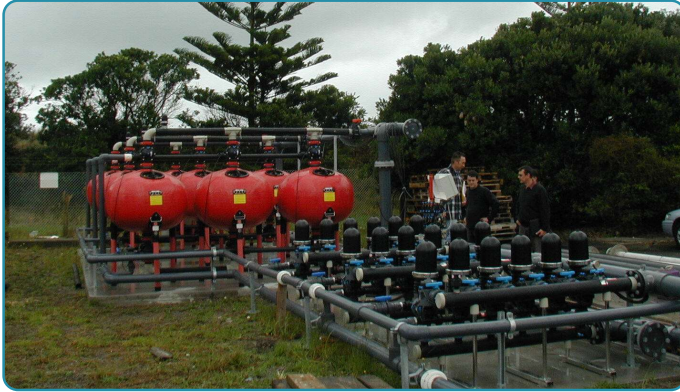
Balık çiftliği, deniz suyu filtrasyonunda ARKAL Diskli ve Kum Filtreleri.
