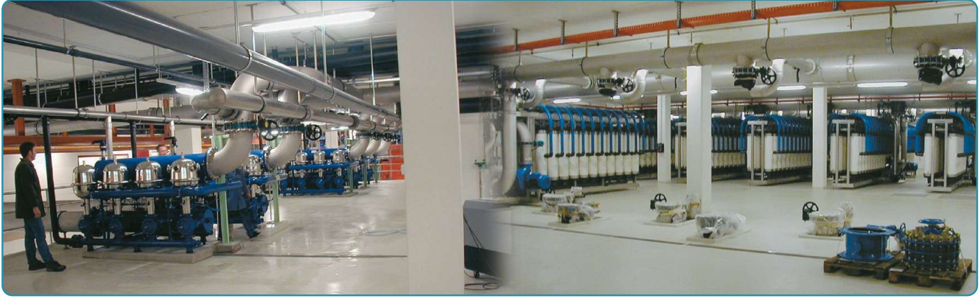
İsviçre'de, şehir şebeke suyu hazırlama sisteminde, Ultra Filtrasyon öncesi kullanılan, tam otomatik ters yıkamalı ARKAL Diskli Filtreler, 2 grup x 560 m 3 /h.
