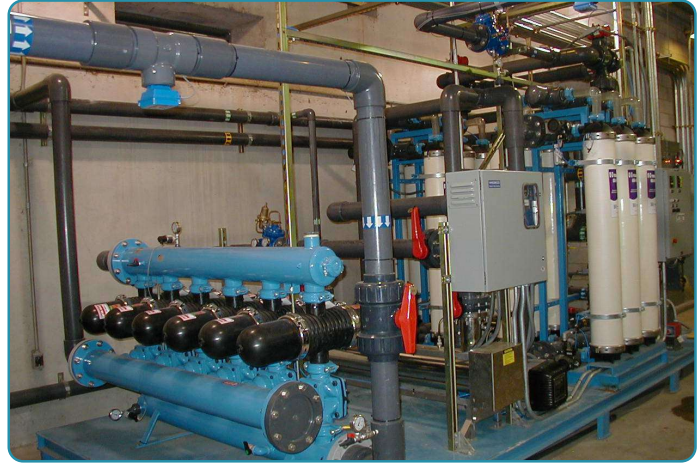
ABD'de, Ultra Filtrasyon öncesi kullanılan, ARKAL Diskli Filtreler, 200 m 3 /h.
