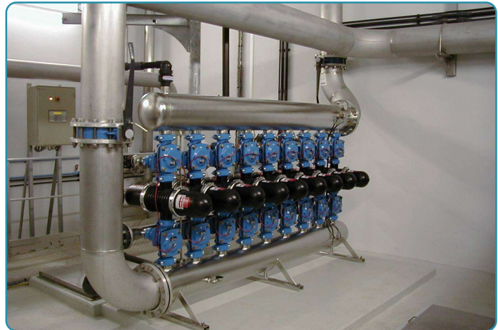
ABD'de, Ultra Filtrasyon öncesi kullanılan, ARKAL Diskli Filtreler, 270 m 3 /h.
