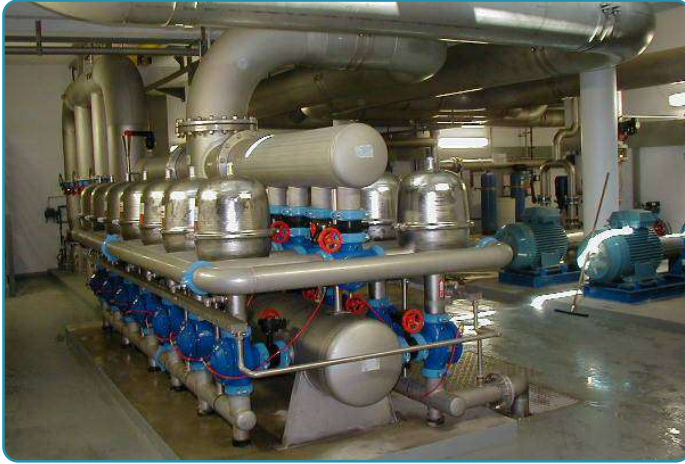
Avrupa'da, Ultra Filtrasyon öncesi kullanılan, ARKAL Diskli Filtreler, 1400 m 3 /h.
