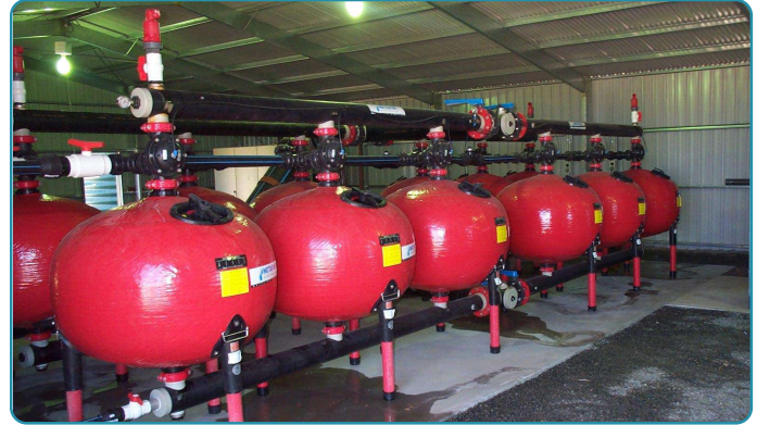
Balık çiftliğinde, deniz suyu filtrasyonunda ARKAL KUM Filtreleri.
